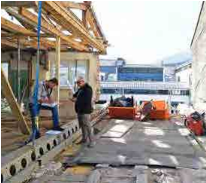
Baustellenfotos: Architekt Gerhard Hauser
