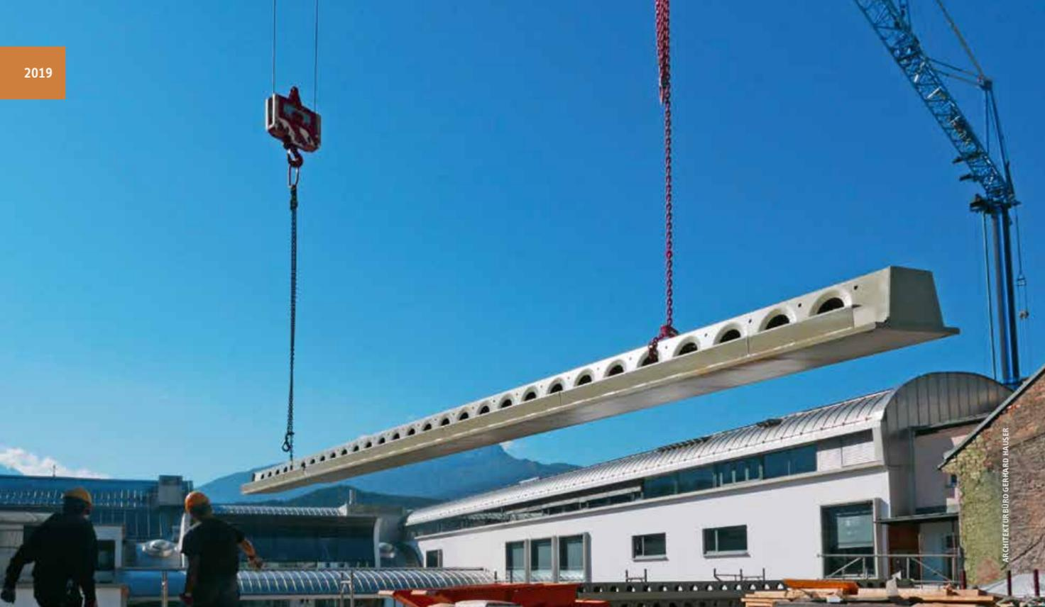
▲ Die trapezförmigen Träger der Verbunddecken werden installiert
