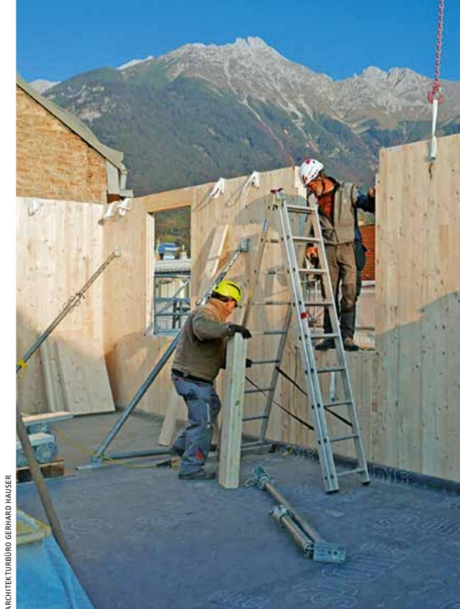
▲ Die ersten Brettsperrholz-Wandelemente werden montiert
