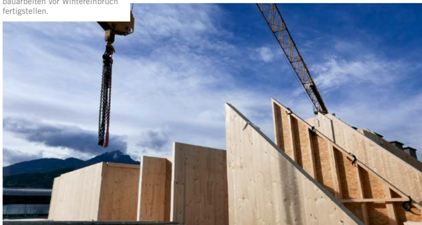
Die Massivholzwände wurden wie ein Kartenhaus von Westen nach Osten aufgebaut. Dank dem Wetter konnte man die Rohbauarbeiten vor Wintereinbruch fertigstellen.
